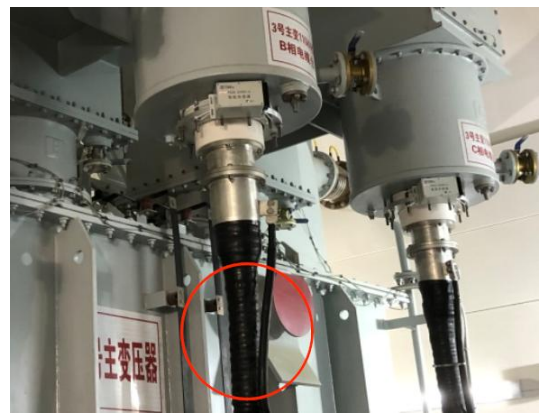
图12：110kV 液体填充复合套管终端应用
