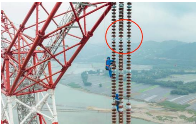
图9：白鹤滩 - 浙江 ±800 千伏特高压直流输电工程 跨江铁塔绝缘子清扫作业
