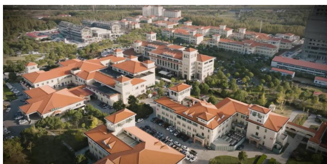
图 20：复旦大学附属公共卫生临床中心采用磁悬浮变频离心冷水机组
