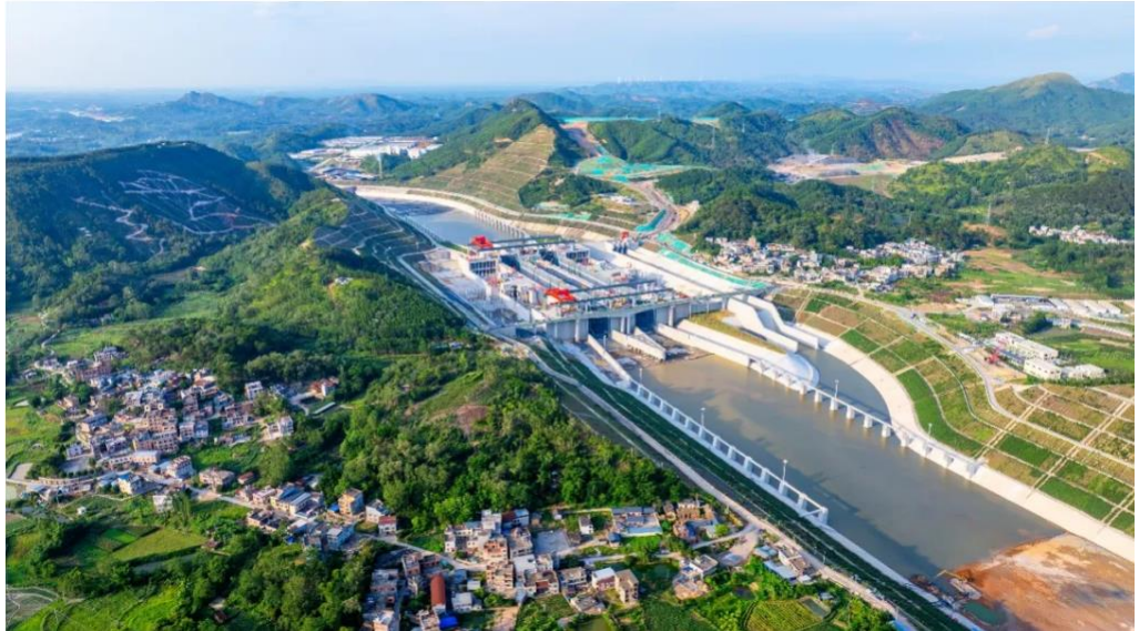
图表 1-1. 广西平陆运河马道枢纽充水现场
