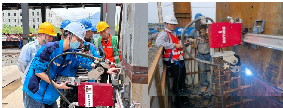
图 3.1.6-8 便携式焊接机器人应用场景
