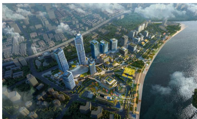
图 3.3.3-5 徐汇西岸中環 D 街坊项目 BIM+智能工装施工管控
