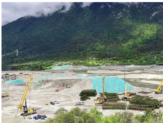
图表33：徐工旋挖钻机群参与川藏铁路高原桥桩施工
