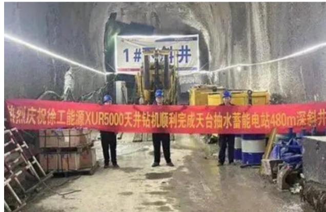
图表34：徐工 XUR5000 天井钻机完成浙江天台抽水蓄能电站深斜井施工任务
