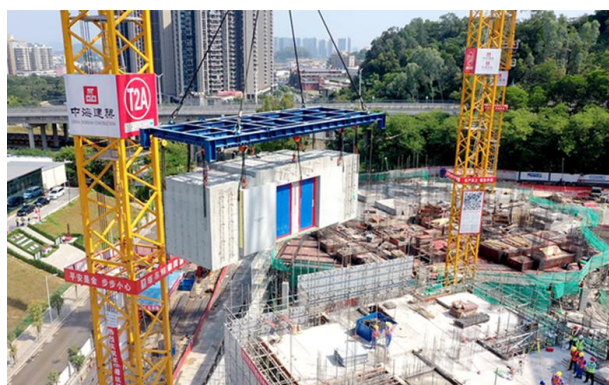
图6：深圳市人才安居集团龙华樟坑径保障性租赁住房 MiC 装配式项目
