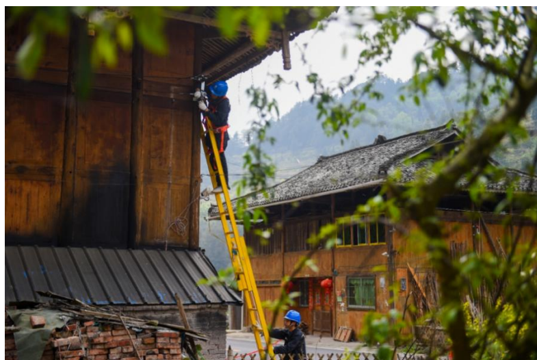
图 凯里供电局员工在贵州台江县南宫镇交宫村开展“消防电改”工作
