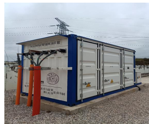
图 基于全国产IGCT元器件的全控电流源智能融冰装置
