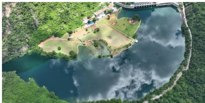
图 南网储能公司天生桥二级电站水库区域航拍图
