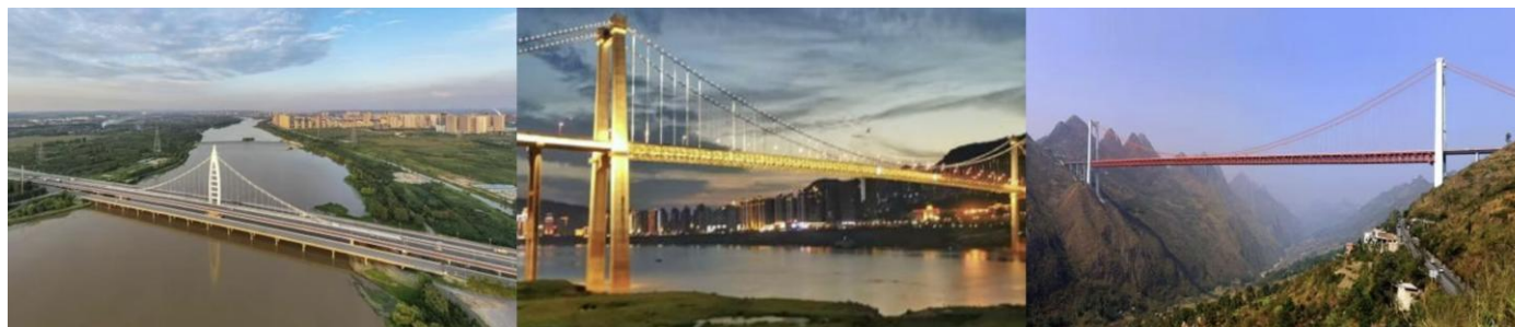
图1：公司参建的项目包括沈阳高坎浑河大桥、万州长江二桥和贵州坝陵河大桥等
