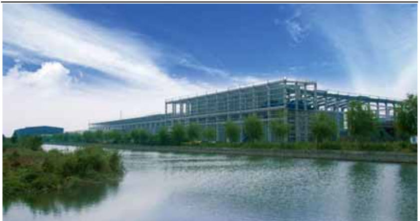
图表 15. 上海青浦生活垃圾综合处理厂
