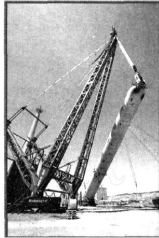
图 9: 一重制造的世界最长最重加氢反应器
