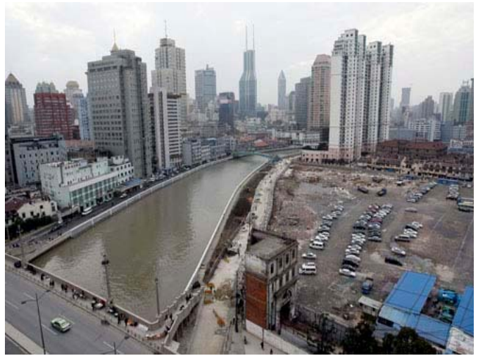
图 3 上海苏河湾项目用地实景
