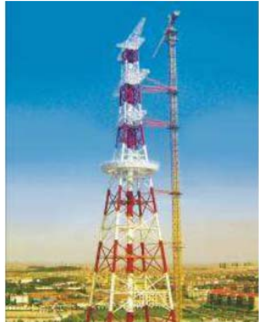
500KV 杨行杨高线上海吴淞口大跨越钢管塔
