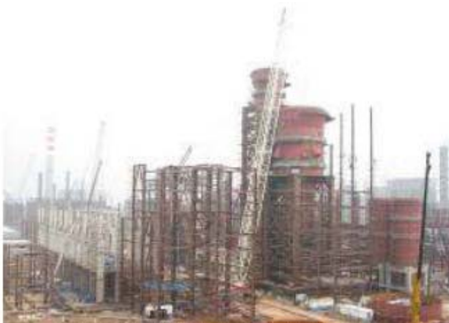
中石化青岛大炼油钢结构工程
