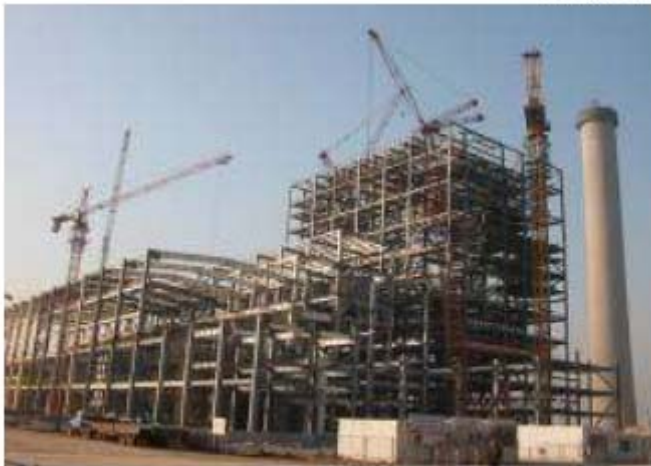
华电国际邹县电厂四期 2×1000MW 主厂房钢结构工程
