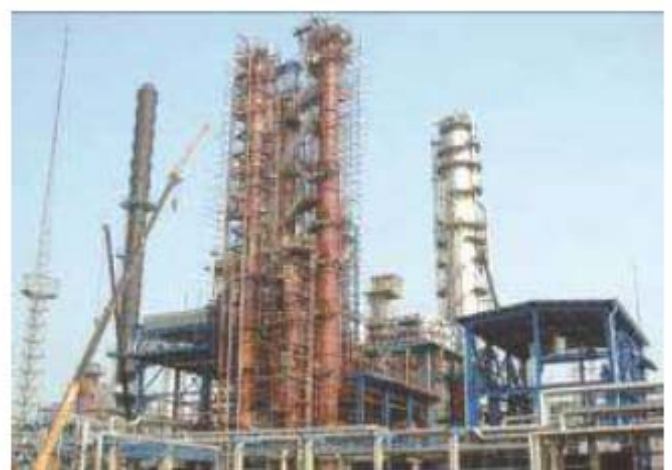
伊朗 SHAZARAK 炼油厂扩建钢结构项目
