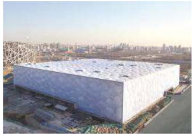
国家游泳中心“水立方”钢结构工程
