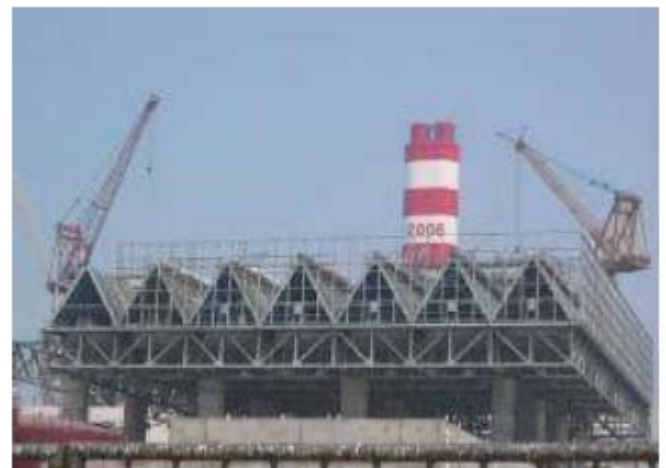
山西漳山电厂 2×600MW 空冷平台钢结构工程
