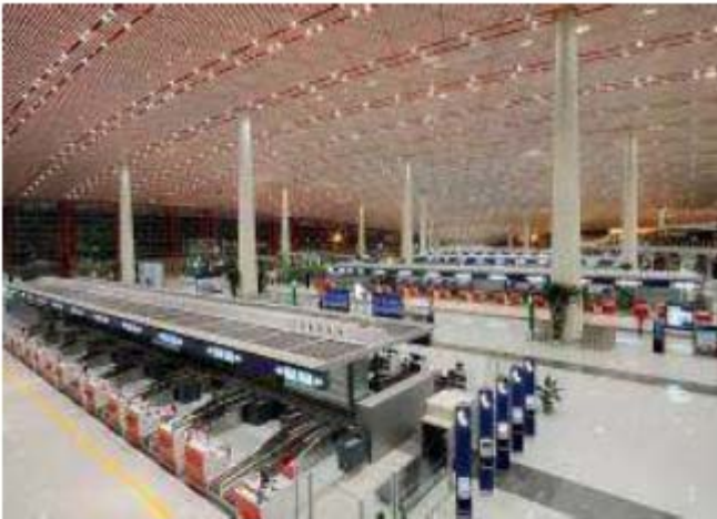
北京首都机场扩建（三期） T3A 航站楼钢管柱工程
