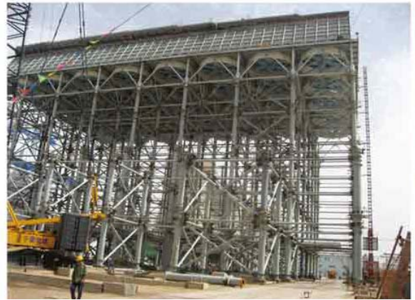
大唐宁夏大坝空冷机组空冷岛钢结构
