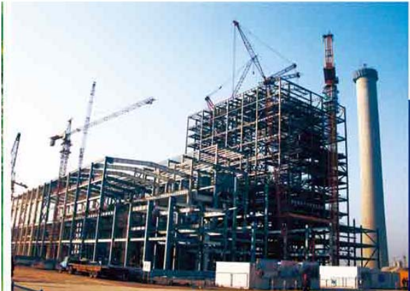
邹县电厂 4 期超超临界机组主厂房
