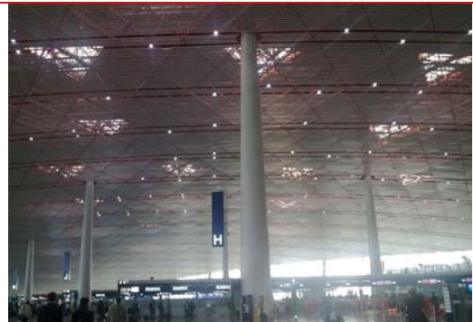
北京国际机场 T3 航站楼
