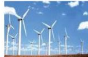
风力发电设备
