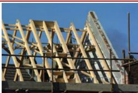
建筑业（结构件、屋顶）
