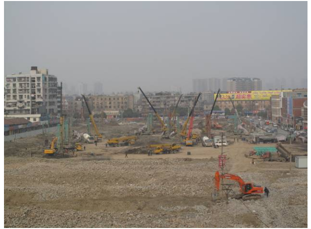
图 7: 大武汉家装二期近 10 台挖土机同时施工
